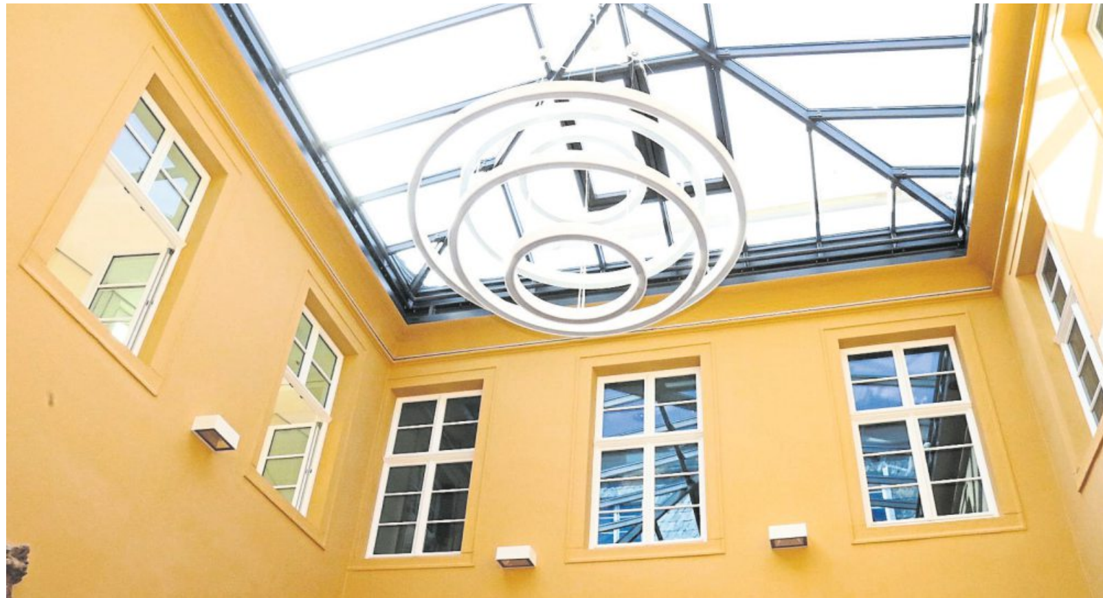
Knapp über drei Millionen Euro haben die Arbeiten am Rossi-Haus verschlungen. Das Ergebnis allerdings kann sich sehen lassen: Nahezu überall im Gebäude trifft edler Barock auf modernen Stil – eine Mischung, die absolut zu überzeugen weiß.
