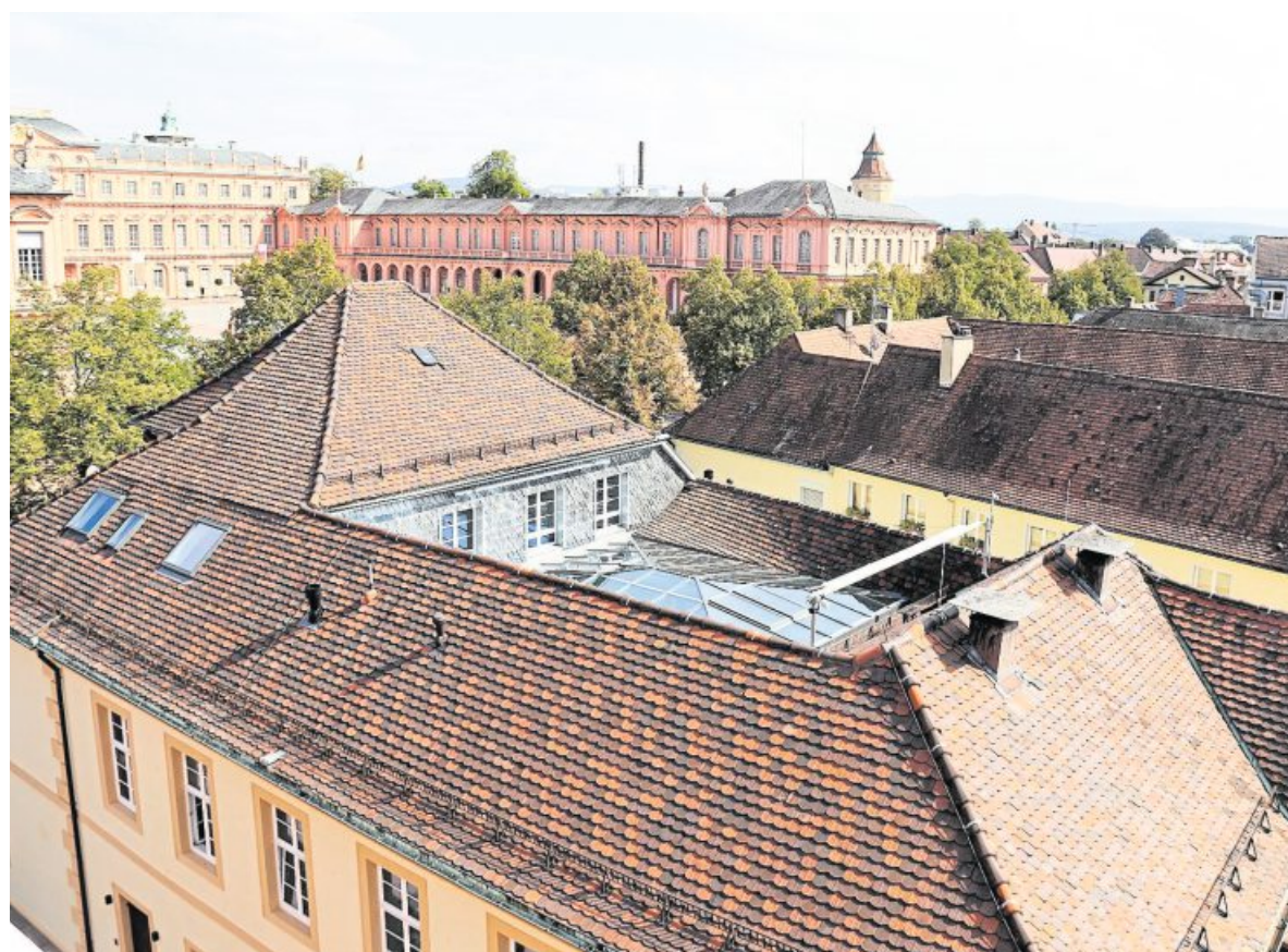
Um das denkmalgeschützte Rossi-Haus für seine künftigen Bewohner nutzbar zu machen, waren umfassende Sanierungs- und Umbauarbeiten notwendig.
